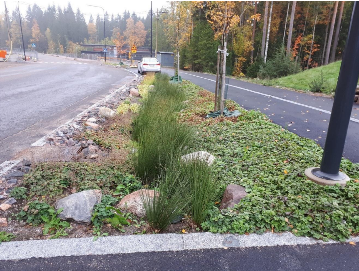
KUVA 5. BIOSUODATUSRAKENNE HELSINGIN KUNINKAANTAMMESSA
