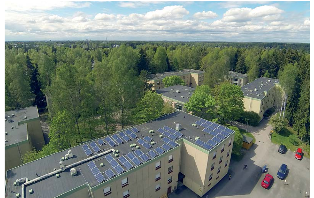
Suomen ensimmäisen kerrostalon itse investoima aurinkovoimala Oulunkylässä Helsingissä. Nimellisteho 15 kilowattia. Asennus: Solarvoima Oy. Kuva: Janne Käpylehto
