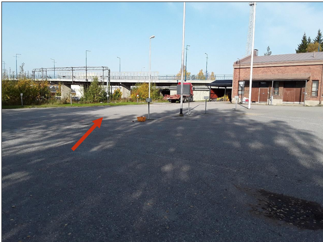
Kuva 4-2 Piha-alue, vanha bensiinisäiliön kohta osoitettu nuolella
