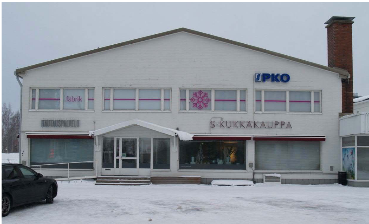
Alkuperäiset puhtaaksimuuratut punatiiliseinät on slammattu/maalattu valkoiseksi.
