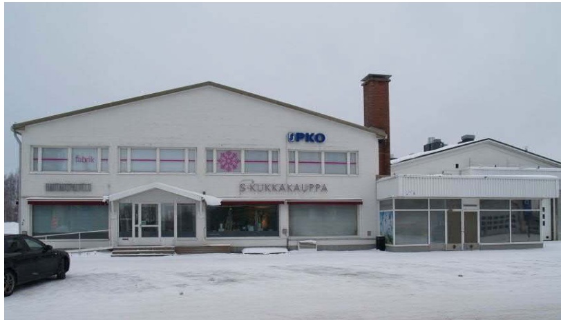
HUOLTOKORJAAMO SALOMAA-SAROLA OY Unto Tupala 1960 ja 1964
