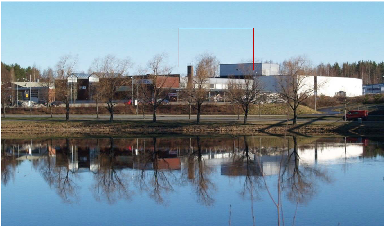
Nykyinen Carlson-tavaratalo on rakentunut useassa eri vaiheessa arkkihti Unto Tupalan vuonna 1961 suunnitteleman autoliike Kemiläisen rakennuksen ympärille.
