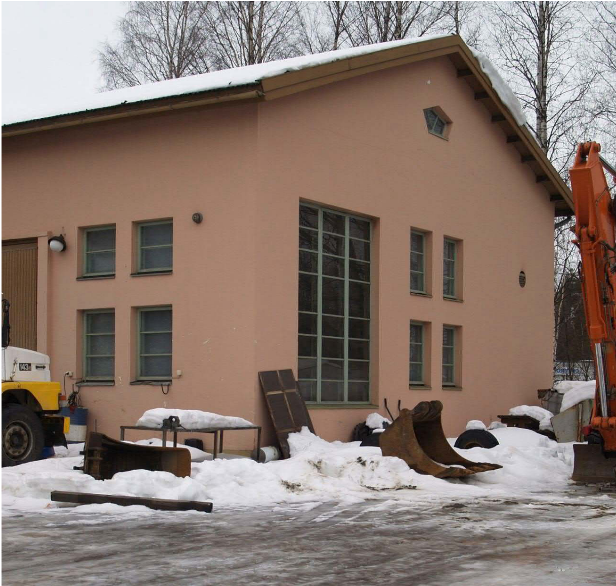
Korjaamorakennuksen pohjoispääty ja asunto-osan sisäänkäynti.
