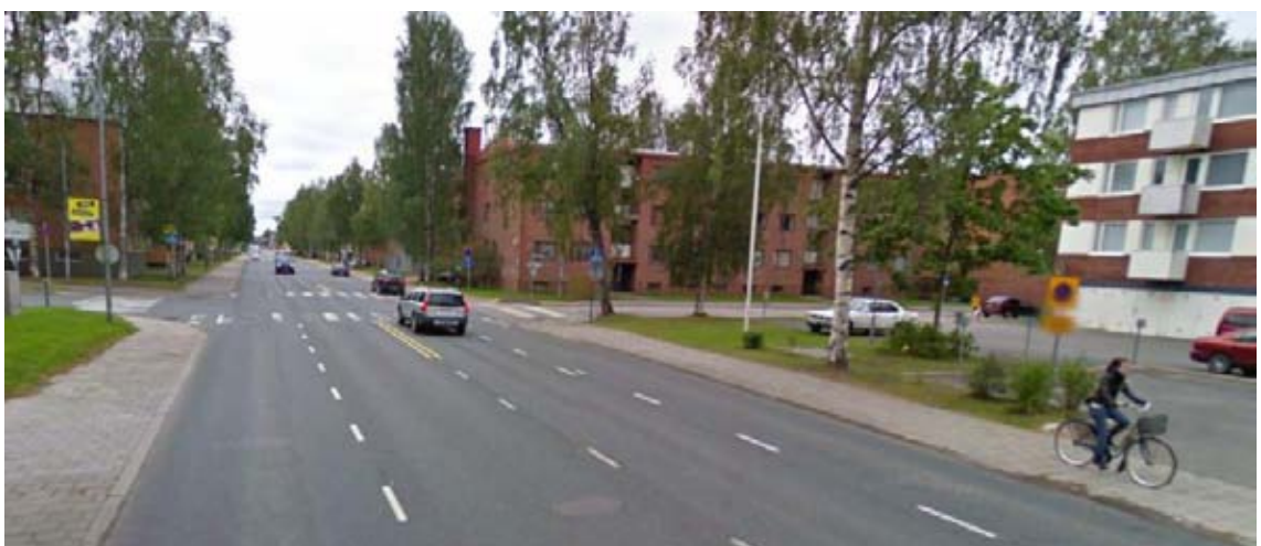
Kuva 4.13. Koulukatu Sairaalakadun liittymän kohdalla on tyypillistä Koulukatua leveine ajoratoineen ja pitkine suojateineen. Kadun ylittäminen on vaikeaa ja turvaton. Pyörätienä toimii kapea jalkakäytävä betonilaatoituksineen (kuva Google 2009).
