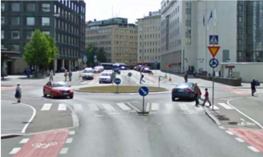
Kuva 2.3. Esimerkki kiertoliittymästä Helsingin keskustassa Runeberginkadun ja Salomonkadun liittymässä (Google Maps 2009). Valo-ohjatun liittymän vasemmalle kääntymiskaistoja ei kiertoliittymässä tarvita.
