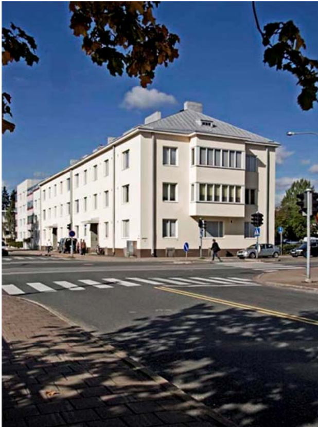
Funktionalistista tyyliä edustava nk. Tshokkisen talo valmistui Koulukadun ja Niskakadun kulmaukseen vuosina 1937 – 1938. Se on ruutukaavan ensimmäinen kivinen puhdas asuinkerrostalo. Kuva Pekka Piiparinen (2010)
