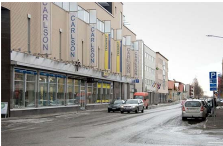
Kortteliin 40 Torikadun varrelle nousi 2000-luvulla kolme uudisrakennusta, joista kaikkiin julkisivumateriaaliksi tulivat betonielementit. Kahteen rakennukseen väriksi valittiin beige, josta tuli leimallinen väri 2000-luvun Joensuun keskustarakentamiseen. Kuva Pekka Piiparinen (2009)
