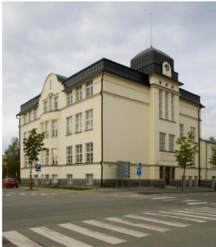
Jugend-tyyliä edustava Joensuun yhteiskoulu (1912) on ainoa Wivi Lönnin suunnittelema kohde Joensuussa. Kuva Pekka Piiparinen (2010)
