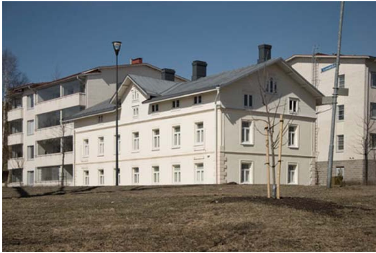
Nk. Pärnäsen talo (1863 – 1883) Papinkadun ja Torikadun risteyksessä on ruutukaava-alueen vanhin säilynyt kivistä rakennus. Kuva Pekka Piiparinen
