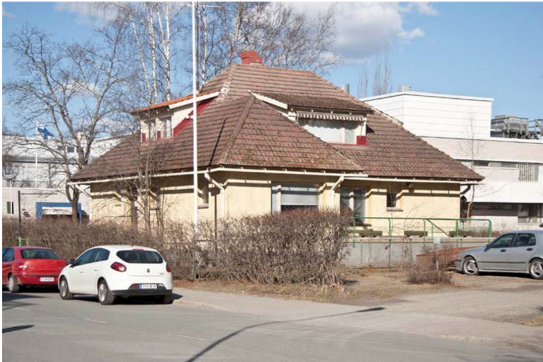
Kalevankatu 26 b:n (1948) on suunnitellut aviopari Martta Martikainen ja Ragnar Ypyä. Rakennus on rakennustaiteellisesti ehkä merkittävin 1940-luvulla valmistunut yksityistalo Joensuussa. Kuva Pekka Piiparinen (2011)
