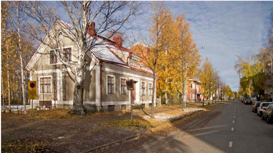
Rakennusmestari Jalmari Mölsä oli 1920-luvun eräs Joensuun tuotteliaimmista suunnittelijoista. Hän suunnitteli mm. kuvassa näkyvän Sepänkatu 31 b:n (1928). Rakennus purettiin kesällä 2011. Kuva Pekka Piiparinen (2010)
