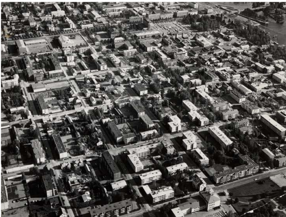
Kuvassa ruutukaava-alueelta vuodelta 1973. Kuvan ottamisen aikaan kaupunkirakenne oli vielä vahvasti muutoksen kourissa, vaikka pääosin nelikerroksiset rakennukset uudistetuissa avokortteleissaan olivat päässeet jo voitolle vanhemmasta rakennuskannasta. Kuva Pohjois-Karjalan museo
