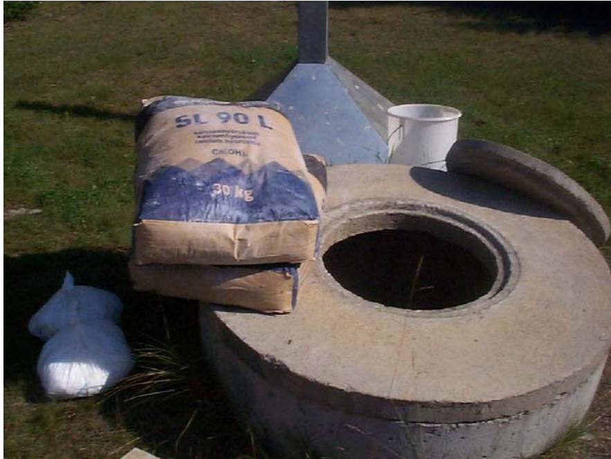
Kuva 1. Varaa kalkkistabilointia varten riittävä määrä sammutettua kalkkia
