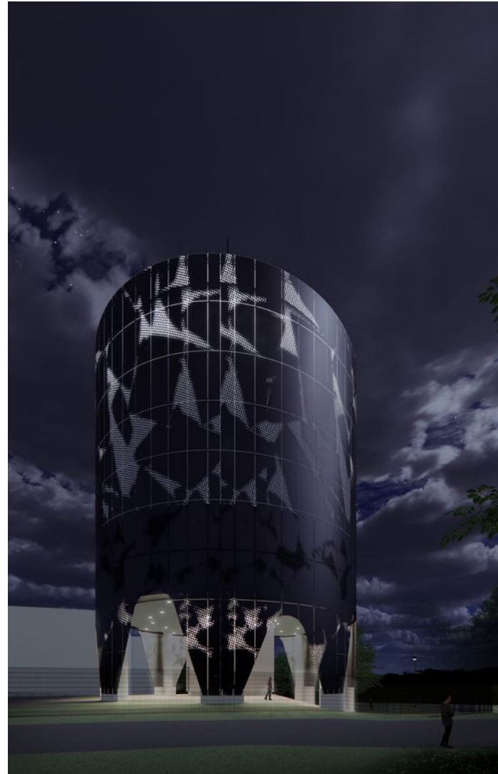
Vesitornin julkisivuun suunniteltu rei'itetty alumiinilevy mahdollistaa taustavalaisun tai hillityt valaistustehosteet.
