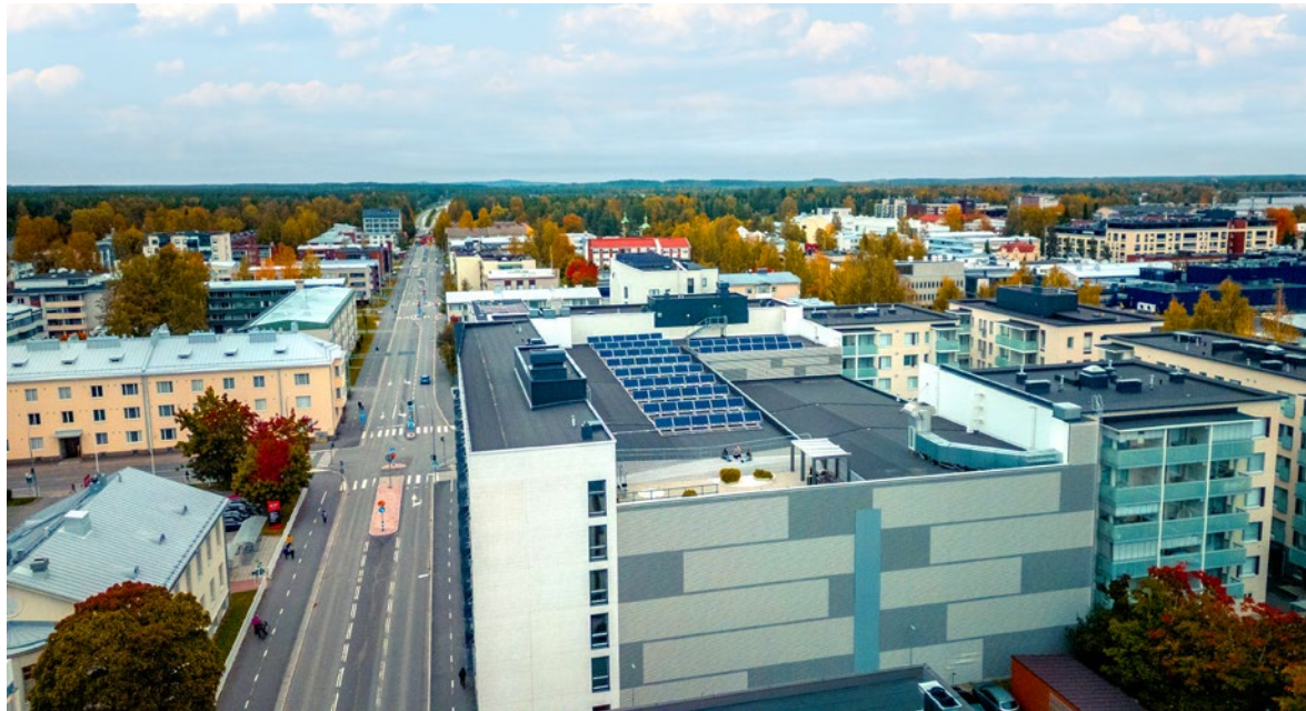
Opiskelija-asuntokiinteistö osoitteessa Niskakatu 15 on yksi Joensuun Ellin aurinkopaneelikohteista.
