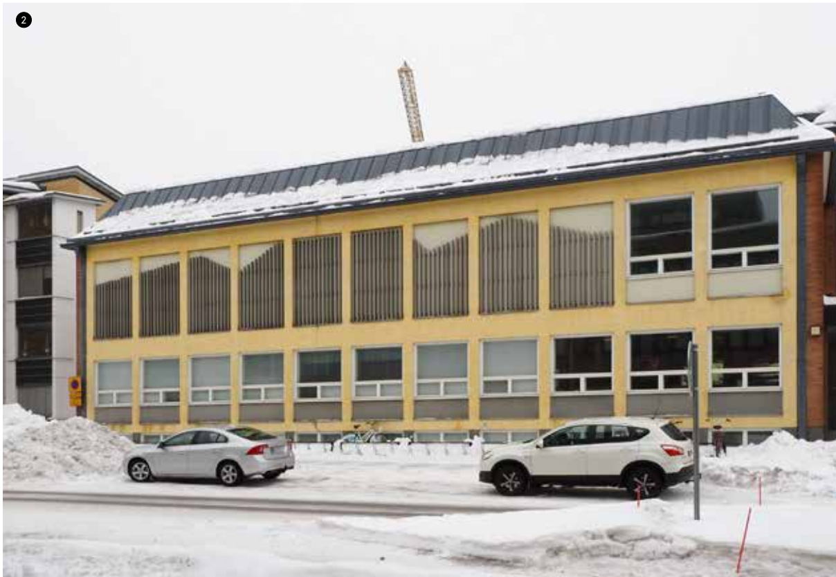
↑ Konserttitali peitettyine ikkunoineen erottuu Yläsatamakadun puolella.
