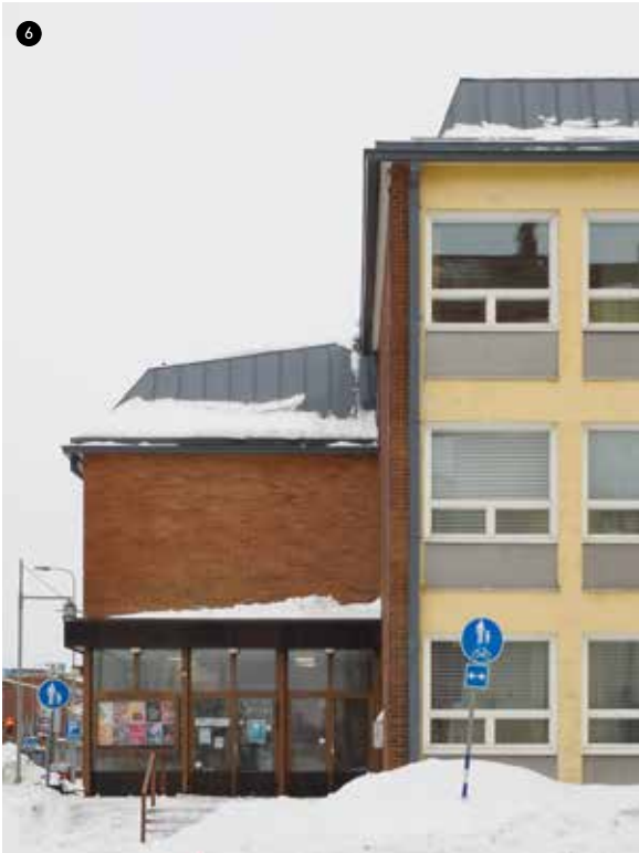
← Rakennuksen pääsisäänkäynti Rantakadun puolella.
