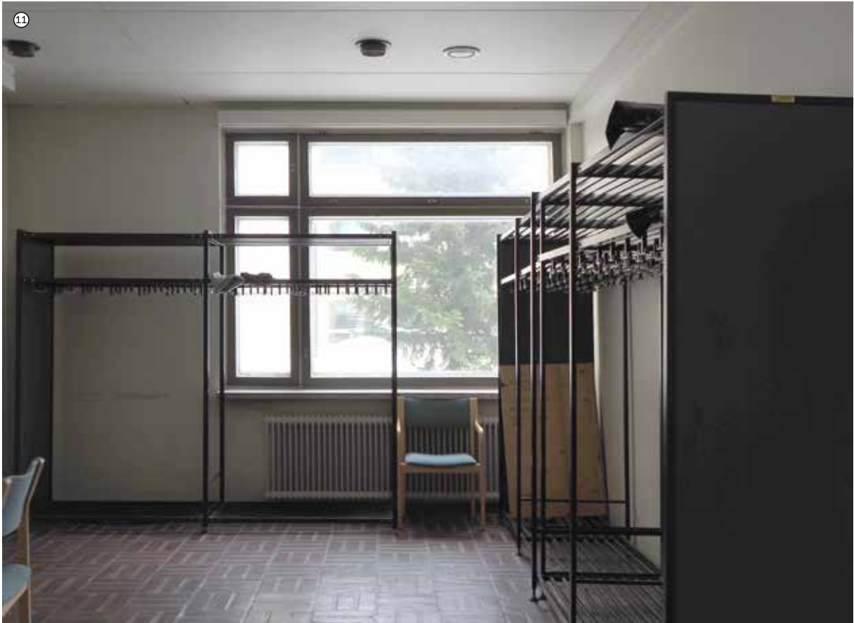
↑ Ravintolan eteistilan lattiapinta on säilynyt alkuperäisenä robustina klinkkerilattiana.
