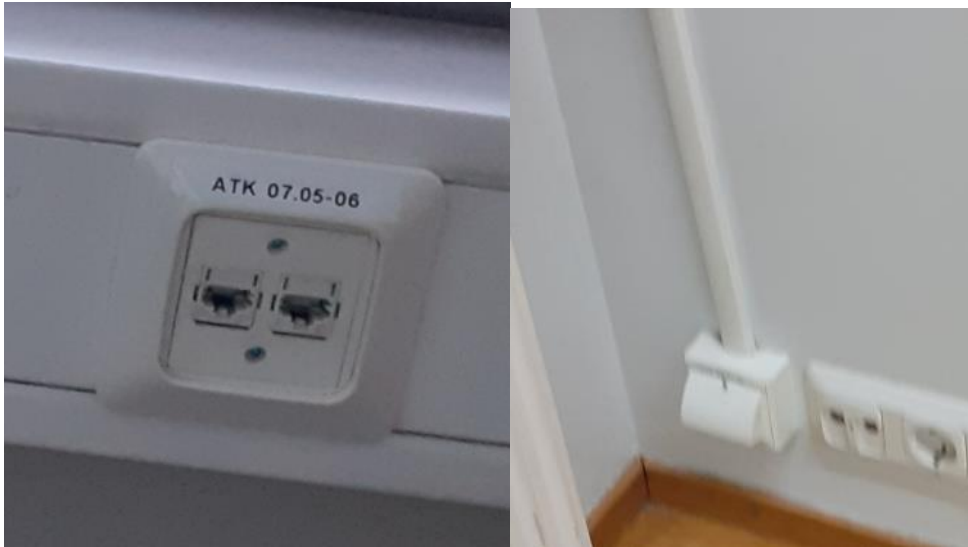
Kuva 15: Yleiskaapeloinnin RJ- rasioita
