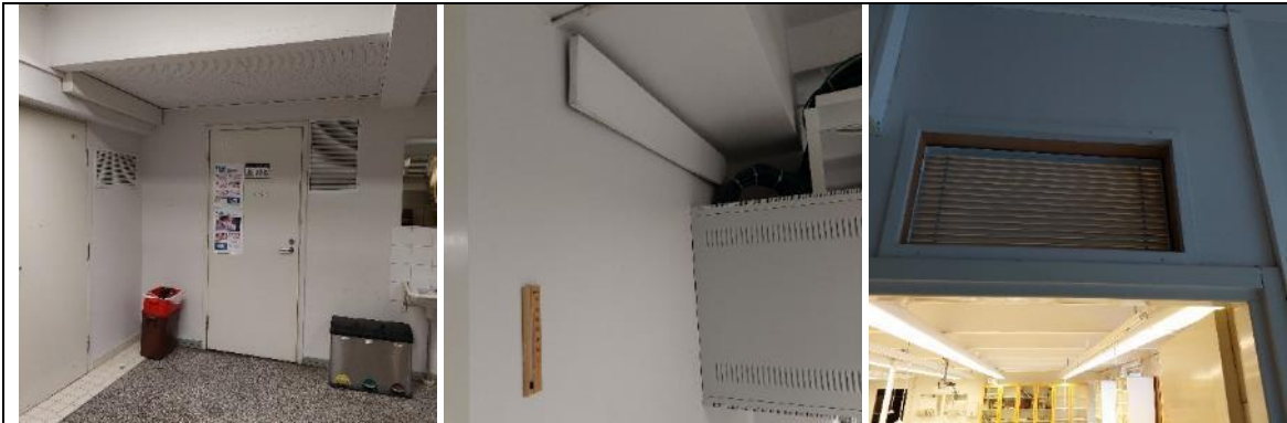
Kuva 89 esimerkkejä siirtoilmasäleiköistä
