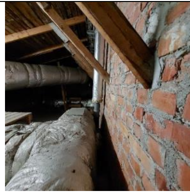
Kuva 77 tuuletusputken eristyksen epäjatkuvuuskohta
