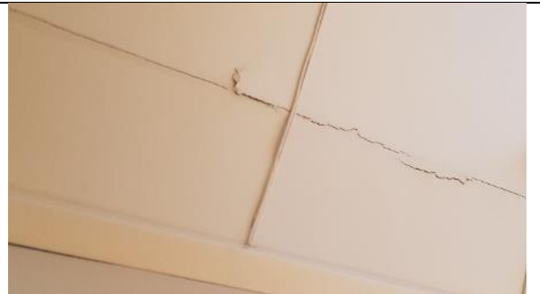
Kuva 46: Halkeama levyrakenteessa
