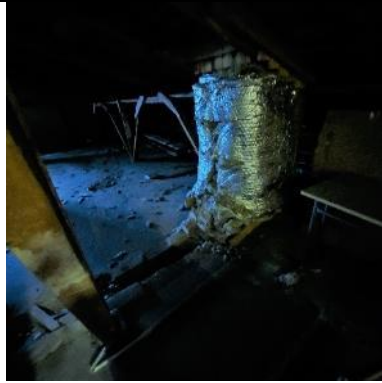
Kuva 92 iv-kanavaeristyksessä puutteita
