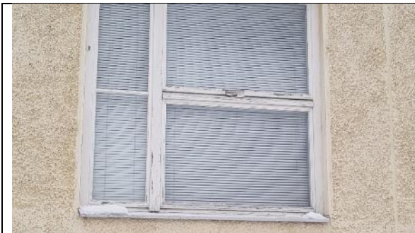
Kuva 17: Ulkopuutteissa vaurioita
