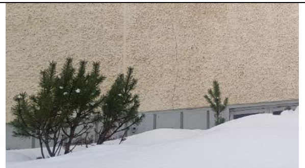
Kuva 11: Halkeama rappauspinnassa
