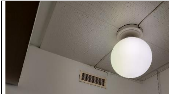
Kuva 45: Akustoivia kipsilevyjä
