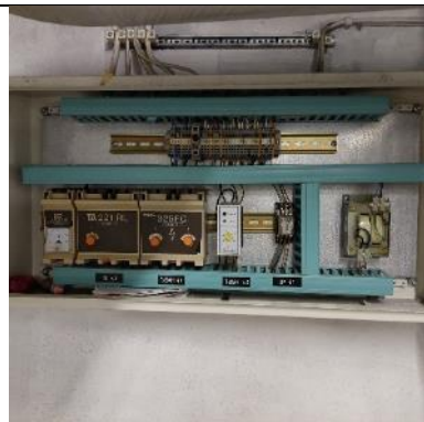
Kuva 106 keittiön iv-koneen säätölaitteet, ei ole liitetty Muuntamontien valvomoon
