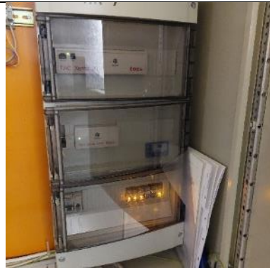
Kuva 102 Xenta-alakeskus VAK01, iv-kone 1TK1
