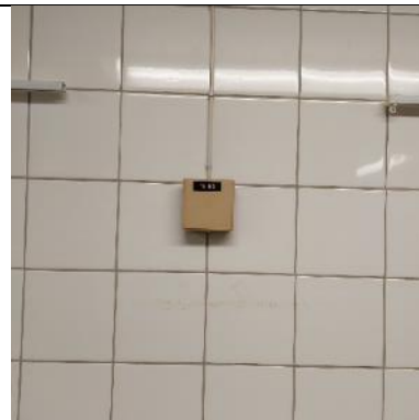
Kuva 107 huonelämpötila-anturi keittiöllä
