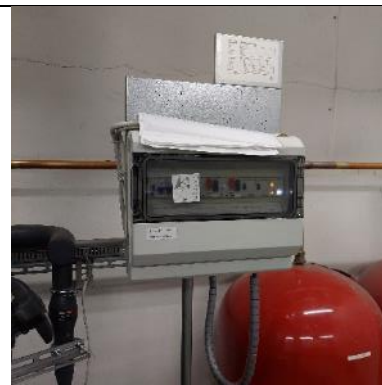
Kuva 56 lämmityksen pumppukeskus
