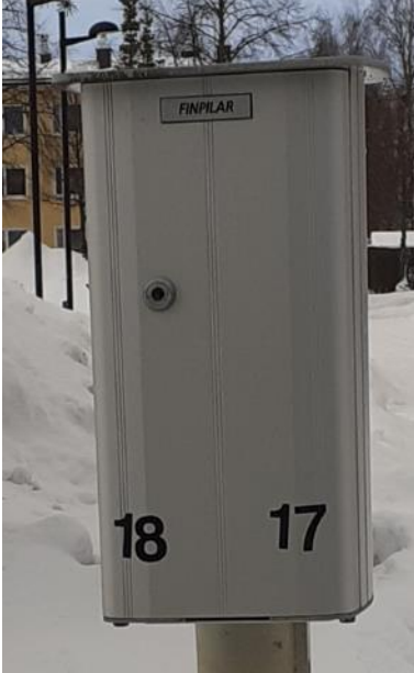
Kuva 3: Autolämmityspistorasia kotelo
