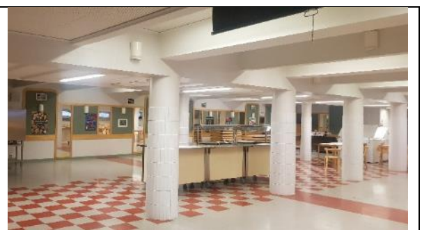
Kuva 5: Palkkeja ja pilareita kellarikerroksessa
