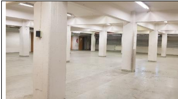
Kuva 17: Matalan osan kellarin pilarit ja palkit
