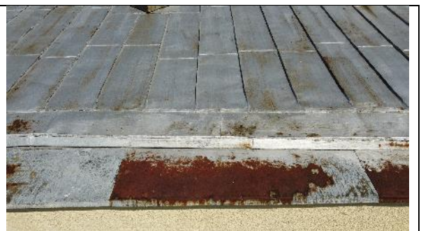
Kuva 42: Ruostevaurio räystäällä
