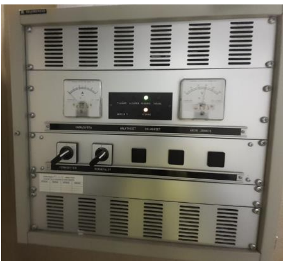
Kuva 16.1: Pääkeskushuoneen turvalokeskus
