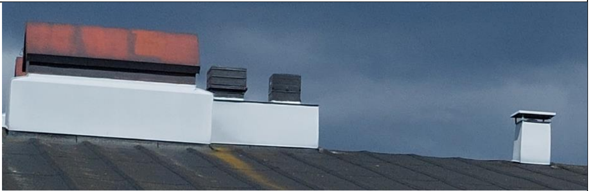
Kuva 112 erilaisia ulospuhalluskatoksia
