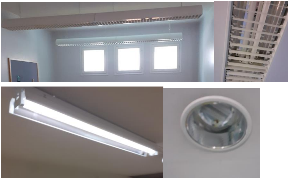
Kuvat 15: Sytyttimellä varustettuja loisteputkivalaisimia ja pienoisloisteputkivalaisin
