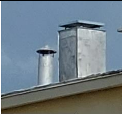
Kuva 113 erilaisia ulospuhalluskatoksia
