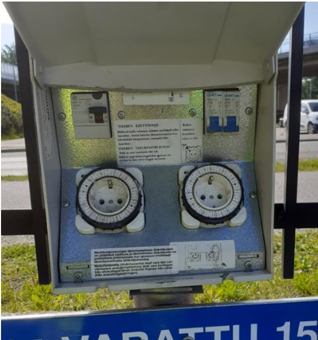
Kuva 13: Autolämmityspistorasiakotelo
