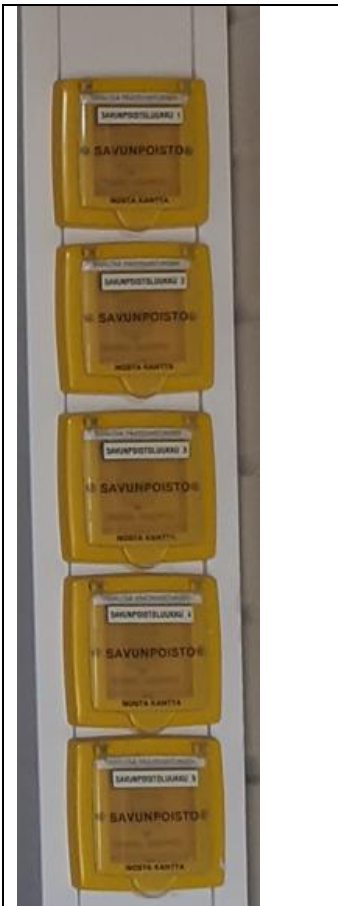
Kuva 120 savunpoistoluukku- jen ohjauskytkimet matalalla osalla
