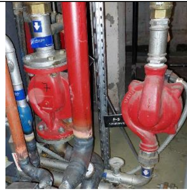
Kuva 73 lämpöjohtopumput v.1990
