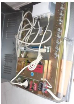
Kuva 19: Ullakkokerroksen antennivahvistin
