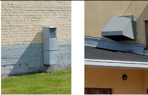
Kuva 111 esimerkkejä ulkoilmasäleiköistä
