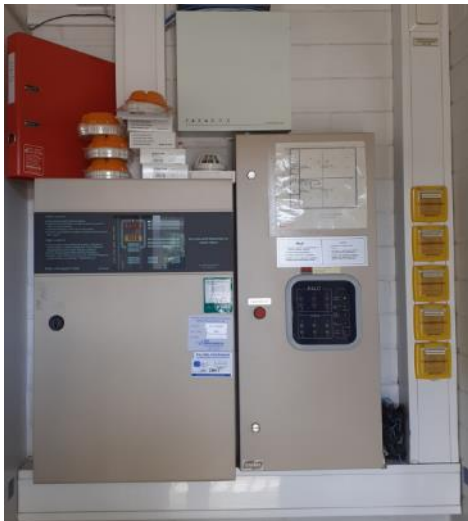
Kuva 21: Paloilmotinkeskus ja savunpoiston laukaisupainikkeet
