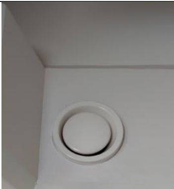
Kuva 116 esimerkkejä päätelaitteista
