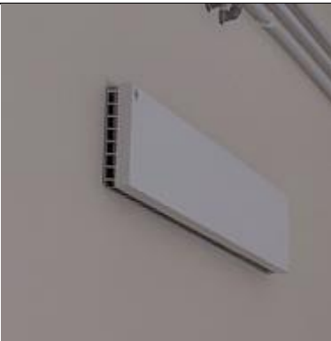
Kuva 117 esim. siirtoilmäsäleiköstä
