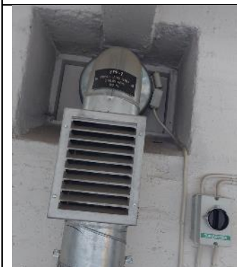
Kuva 107 matalan osan tuloilmakone ullakon konehuoneessa, huom. valuma-alas, tilassa ei ole lattiakaivoa.
