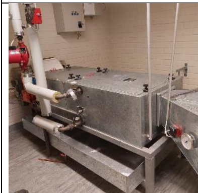
Kuva 107 matalan osan tuloilmakone ullakon konehuoneessa, huom. valuma-alas, tilassa ei ole lattiakaivoa.
