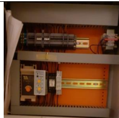
Kuva 131 matalan osan tuloilmakoneen yksikkösäätimet
