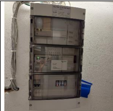
Kuva 126 ainut alakeskus, joka on liitetty etävalvontaan. asennusvuosi 2010
