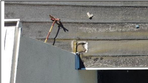
Kuva 47: Purkutyö kesken katolla
