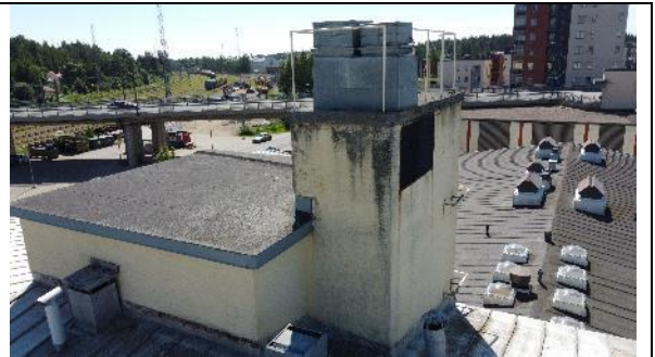
Kuva 40: Yleiskuva porrashuoneen katteesta
