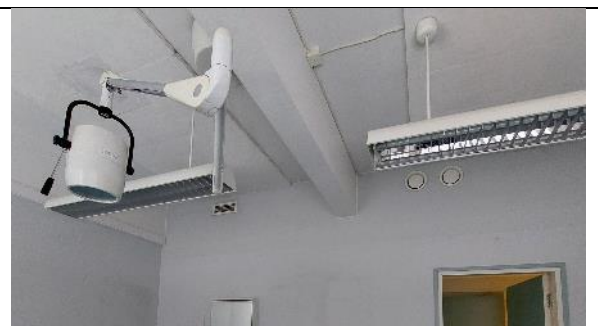
Kuva 65: Betonipintaan liimattuja akustolevyjä
