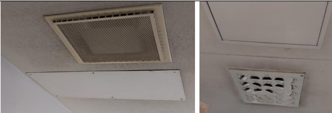
Kuva 118 esim. päätelaitteesta ja tarkastusluukusta
