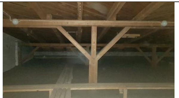
Kuva 20: Matalan osan ullakko
