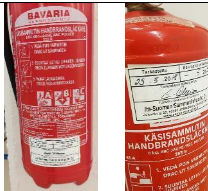
Kuva 124 sammuttimet on huollettu osittain oikea-aikaisesti
