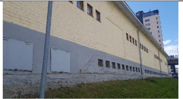
Kuva 24: Matalan osan ulkoseinä
