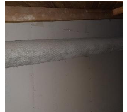
Kuva 104 hyväkuntoiset eristeet matalan osan tuuletusviemärissä ullakolla
