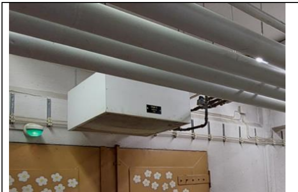
Kuva 81 matalan osan kellarissa kiertoilmalämmitin
