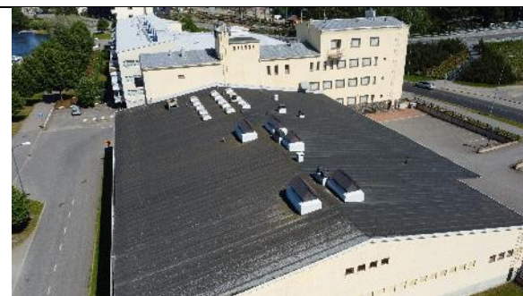
Kuva 41: Yleiskuva matalan osan katteesta
