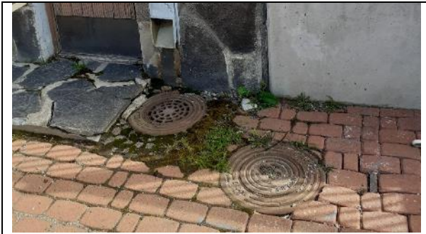
Kuva 4: Tarkastuskaivo rakennuksen nurkalla
