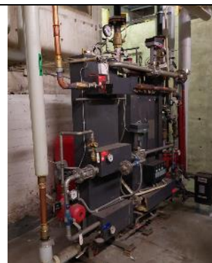
Kuva 70 käyttövesi- ja iv-lämmönsiirtimet v.1990, paketissa mukana pumppukeskus ja säätimet
