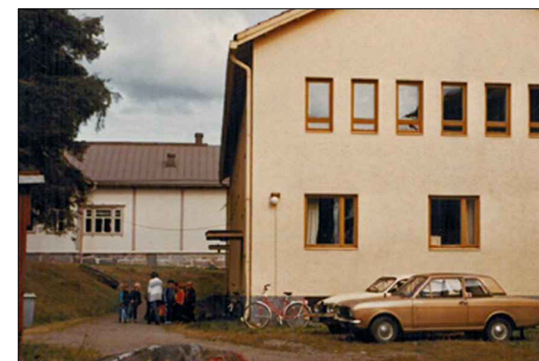
TAUSTALLA NÄKYVÄ ENTISÖITÄVÄ KIRJASTON JULKISIVU
