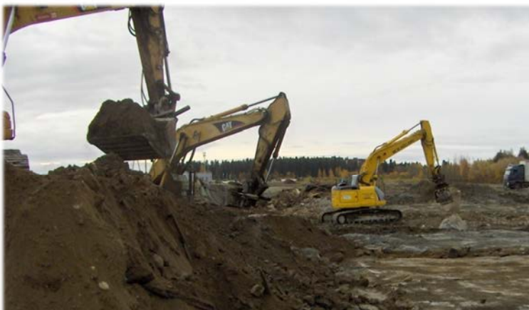
Kuva 9: Saha-alueelta poistettiin täyttömaakerros sekä luontaisen maaperän pintakerros.
