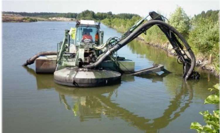
Kuva 8: Imuruoppaaja tukkialtaan koillispuolella.
