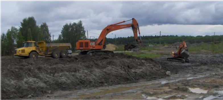
Kuva 6: Jätetäyttöä siirrettiin kaatopaikan reuna-alueilta kaatopaikan keskusta.
