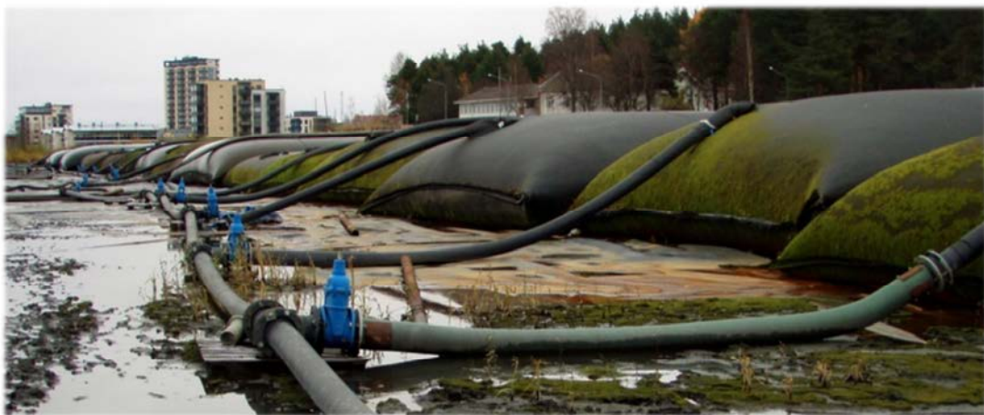
Kuva 13: Tukkialtaasta ruopattua sedimenttiä kuivumassa geotuubeissa.
