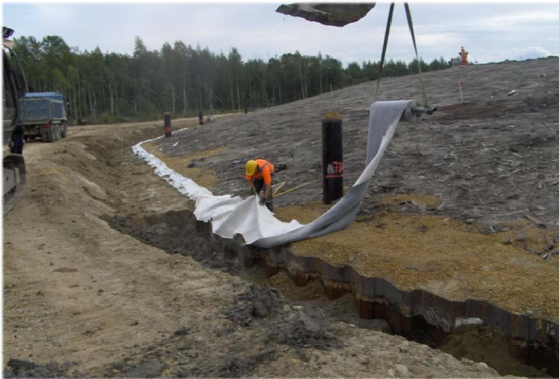
Kuva 12: Kaatopaikka-alueen reunarakenne tehtiin kesän 2009 aikana.
