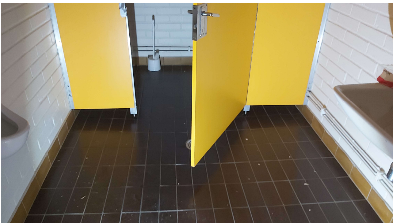
KUVA 2. Asbestinäyte nro 2, 11 WC, Lattialaatan kiinnitys- ja sauma-aine + kosteuseristepiki. Ei sisällä asbestia.
