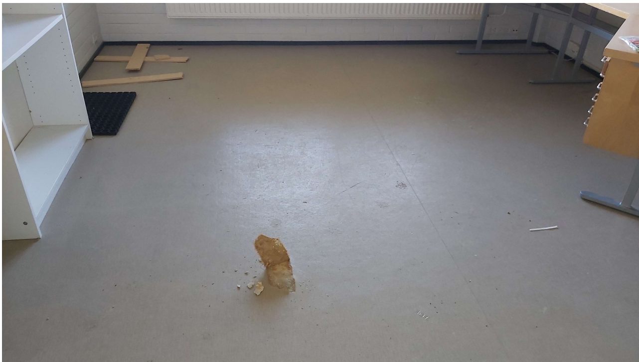
KUVA 9. Asbestinäyte nro 10, 47 OH, Muovimatto (harmaa) + liima + tasoite. Ei sisällä asbestia.
