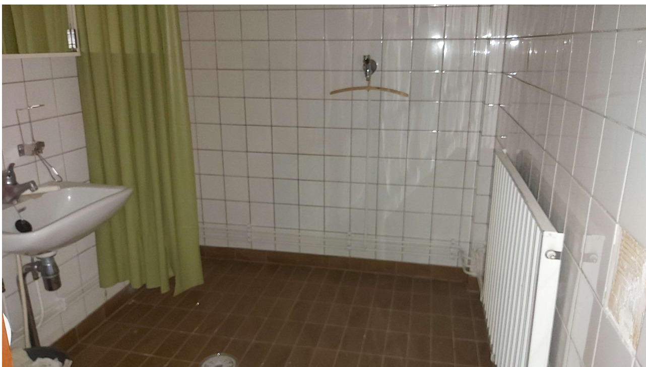
KUVA 10. Asbestinäyte nro 11, 52 KPH, Seinälaatan liima + tasoite + sauma-aine. Ei sisällä asbestia.
