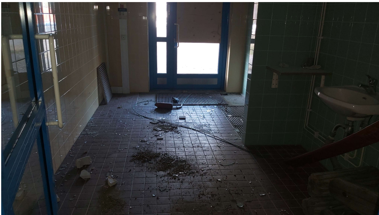
KUVA 6. Asbestinäyte nro 6, 31 Kuraet. Lattiakaakelin kiinnitys- ja sauma-aine + tasoite + kosteuseriste. Ei sisällä asbestia eikä PAH-yhdisteitä yli sallitun.
