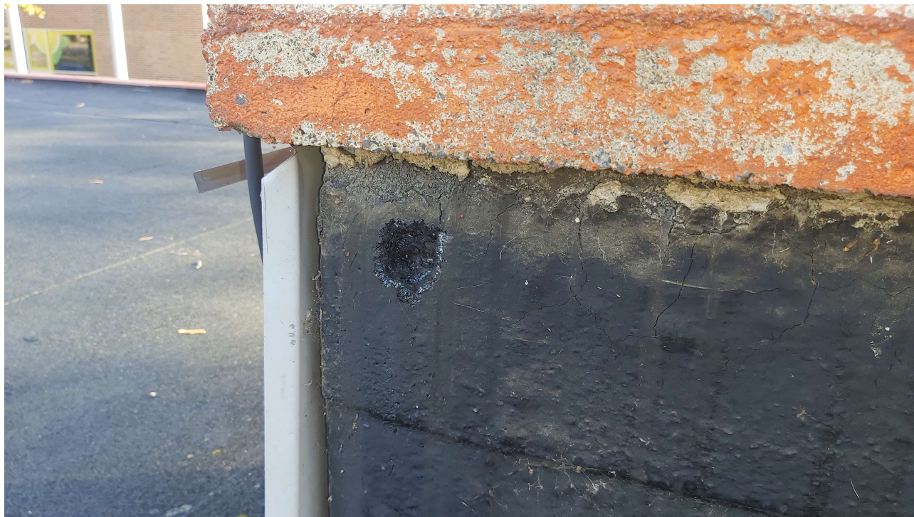
KUVA 11. Asbestinäyte nro 12, Vesikatto, Kattohuopa + piki + pohjahuopa. Ei sisällä asbestia eikä PAH-yhdisteitä yli sallitun.
