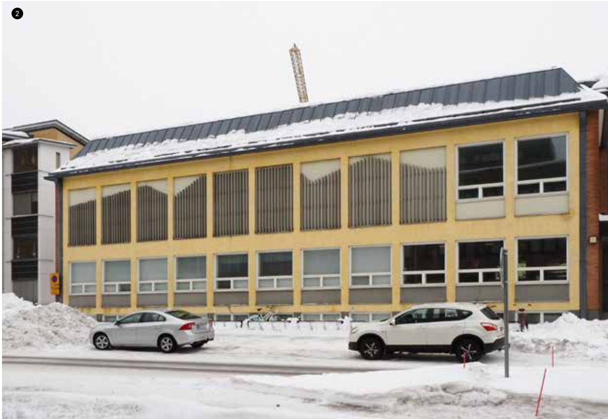
↑ Konserttitali peitettyine ikkunoineen erottuu Yläsatamakadun puolella.
