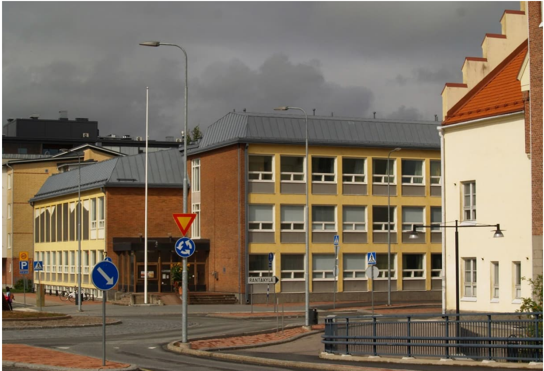
Kuva 2: Entinen kauppaopilaitoksen rakennus Sirkkalan sillalta katsoen (Petri Enqvist, 2021). Rakennus on ollut tyhjiään vuoden 2022 alusta lähtien, eikä kaupungilla ole sille enää käyttöä.
